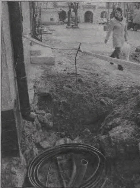
Rozkopany chodnik, kable i rury wystające z ziemi - jeszcze przez kilka dni taki krajobraz będzie normalnością na ul. Mostowej.
