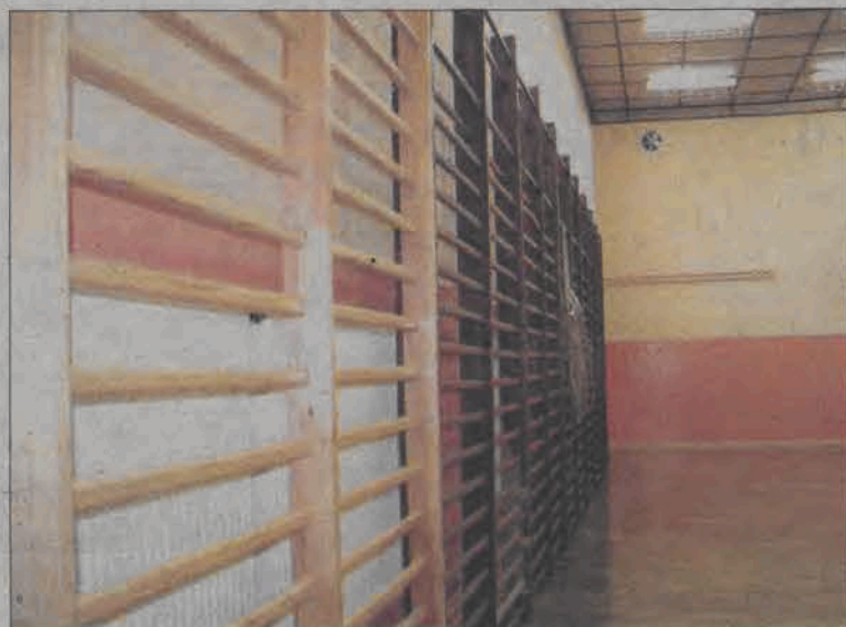
Nowe drabinki i schowane za nimi kaloryfery w odremontowanej sali gimnastycznej.
