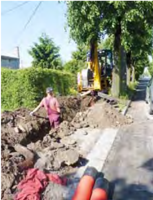
Pracownicy Zakładu Energetycznego w Płocku wymieniają zniszczony odcinek sieci niskiego napięcia w ulicy 3 Maja. Wcześniej wymieniali przewody w ulicy Narutowicza i Barlickiego.
