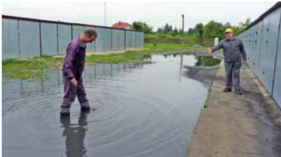
Garaże w miejscu dawnego basenu toną w wodzie. Użytkownicy terenu mają problem, aby do nich dojechać.
