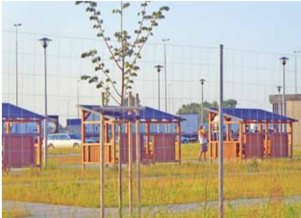
MOP „Polesie”. Altanki na których kierowcy i pasażerowie mogą usiąść i wypocząć w czasie długiej podróży.
