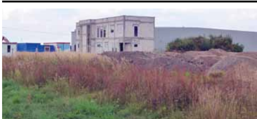
Budowa w Brzozowie. Tu będą powstawały płyty warstwowe na potrzeby producenta mebli.
