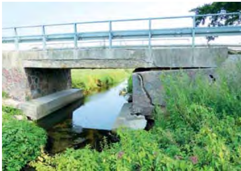
Most w Skaratkach w każdej chwili może runąć. Niestety nadal wiele osób lekceważy to, że jest zamknięty i chodzi po nim pieszo lub jeździ rowerami.
