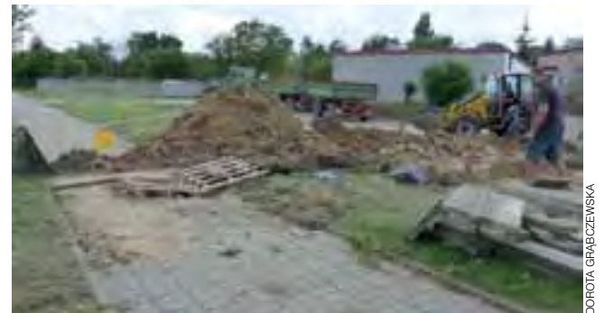
Chodnik i parking przy ulicy Orłowskiego rozkopany. Utrudnienia potrwają kilka dni.
