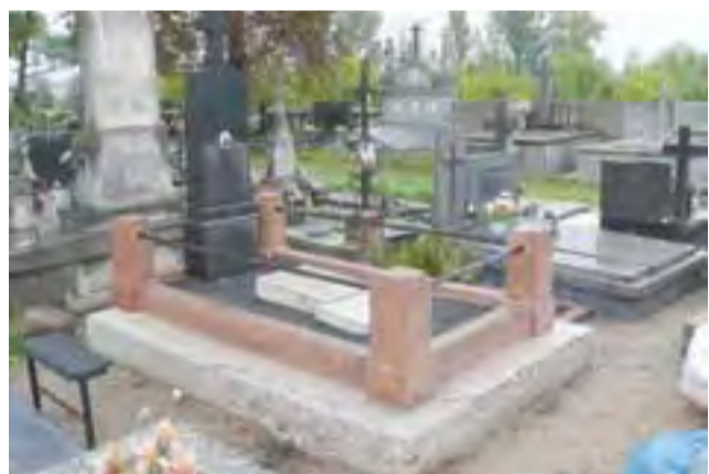
Drobnym pracom naprawczym tynku na fundamencie poddawany jest grobowiec, w którym pochowany jest zasłużony dla Łowicza Maurycy Klimecki. Jego konserwacja została przeprowadzona w 2012 roku.
