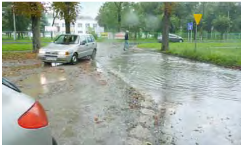
Po każdym deszczu droga gminna na osiedlu Wyzwolenia, koło dawnej porodówki jest zalana wodą, że trudno przejechać. Bywa, że jezioro wody wchodzi nawet na chodnik. To efekt braku kanalizacji deszczowej.
