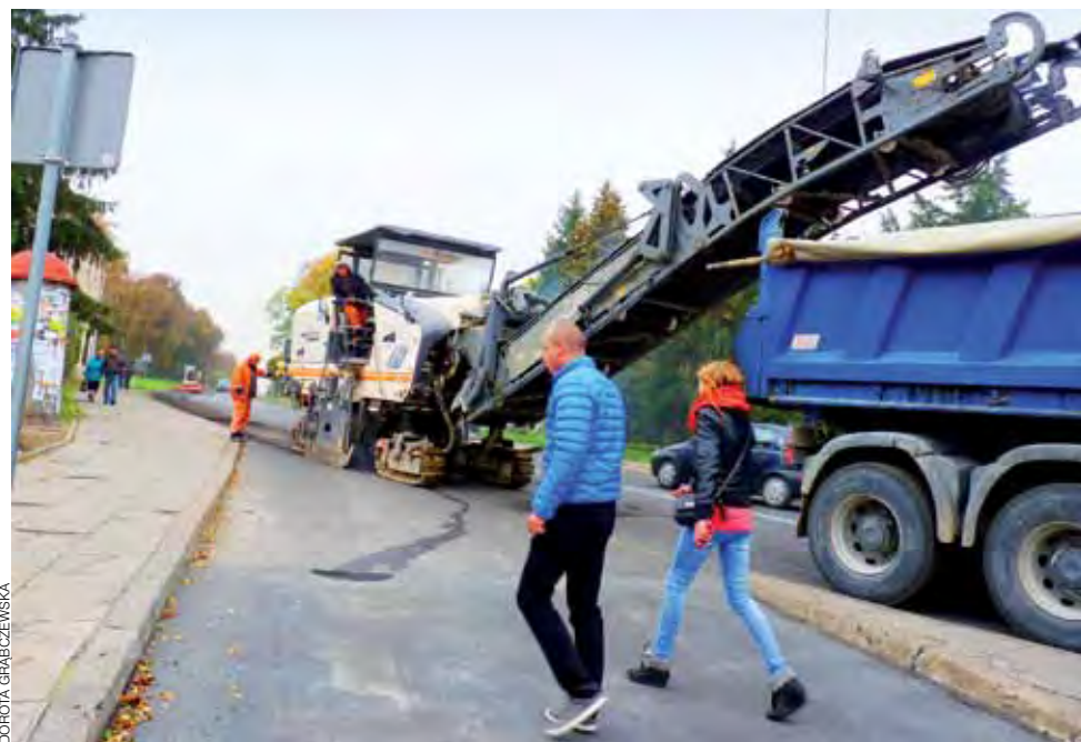
Na zlecenie Wojewódzkiego Zarządu Dróg Wojewódzkich, oddział w Łowiczu ułożony został 800 metrowej długości nowy asfalt w ulicy Narutowicza w Żychlinie, od granic miasta do mostu na rzece
