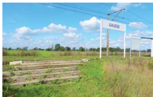
Schodki umożliwiające pasażerom dostanie się na przystanek.
