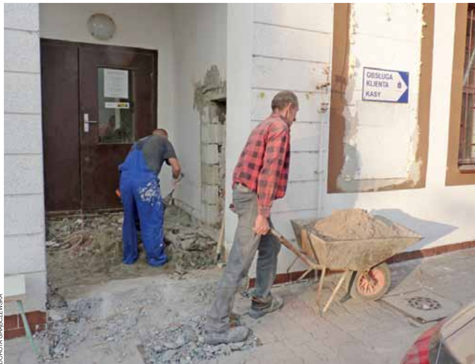
Po zakończeniu remontu bankomat będzie się znajdował w korytarzu banku, a nie na zewnątrz budynku.
