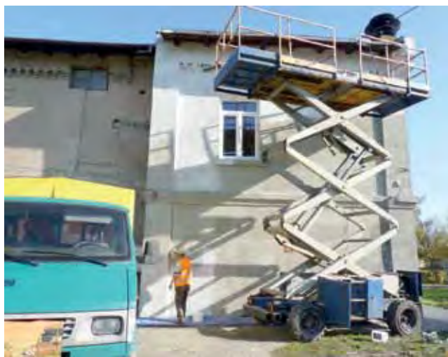
Firma Raf-Det robi elewację strażnicy OSP od strony podwórka.
