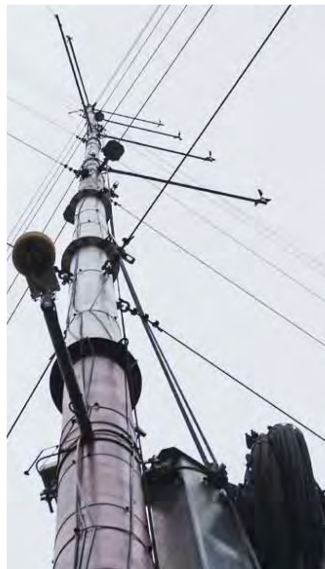
Maszt pomiarowy w Łagowie – pierwsza duża konstrukcja wzniesiona przez Bonwind w gminie Łyszkowice. Kiedy możemy spodziewać się wiatraków?
