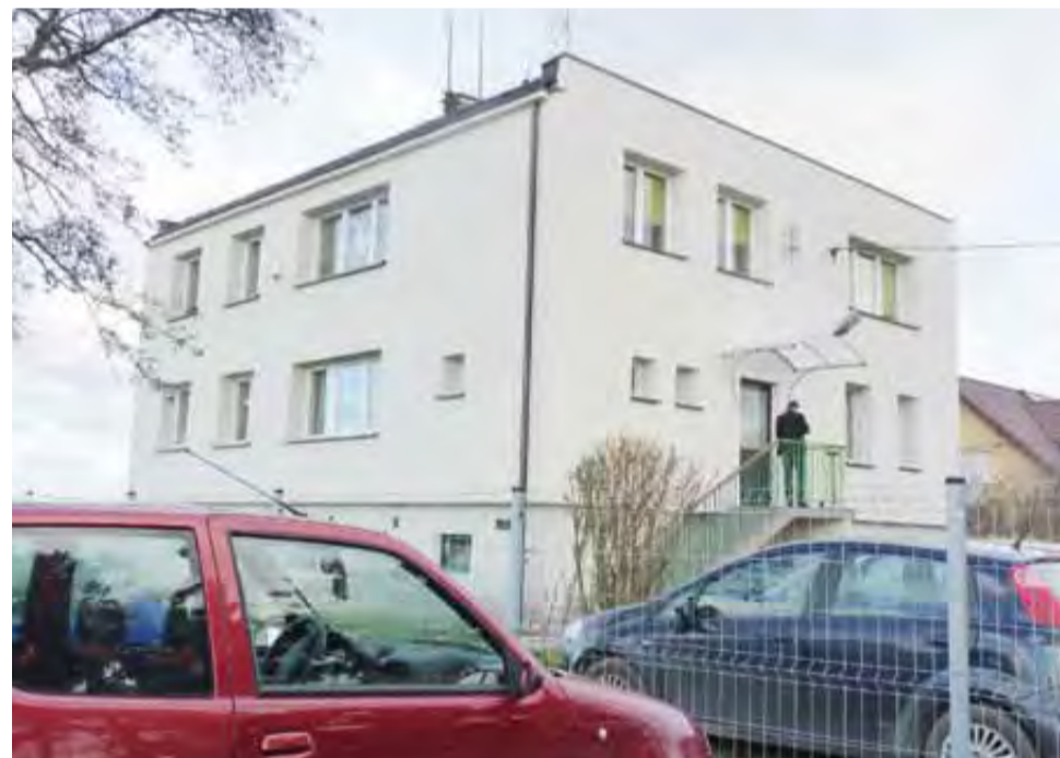
Budynek Urzędu Gminy w Oporowie został docieplony. Do zrobienia zostało docieplenie i elewacja wysokich fundamentów, co mogą wykonać pracownicy w ramach robót publicznych.
