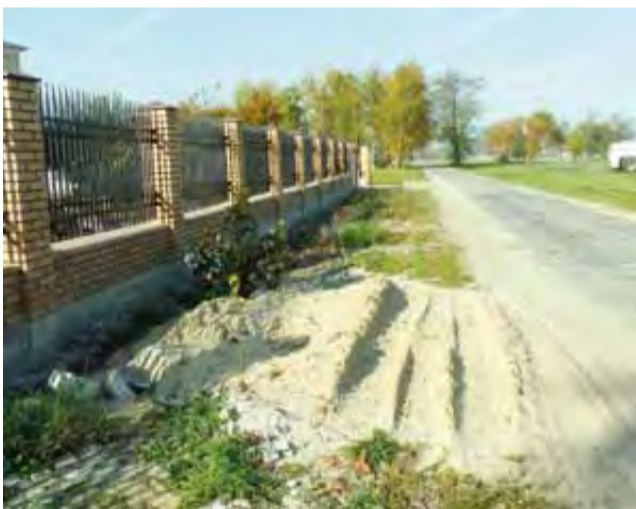
Wola bez przystanku. To tutaj stała murowana wiatła, ale podczas budowy prowadzonej na terenie po byłej szkole została zlikwidowana. Nowa ma stanąć nieco dalej.
