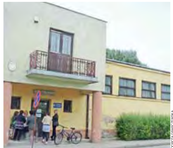
Jeszcze w tym roku ma być zrobiona elewacja na dawnym kinie Lech, w środku którego trwa remont sali gimnastycznej. To dodatkowa inwestycja miasta, by budynek wyglądał estetycznie.
