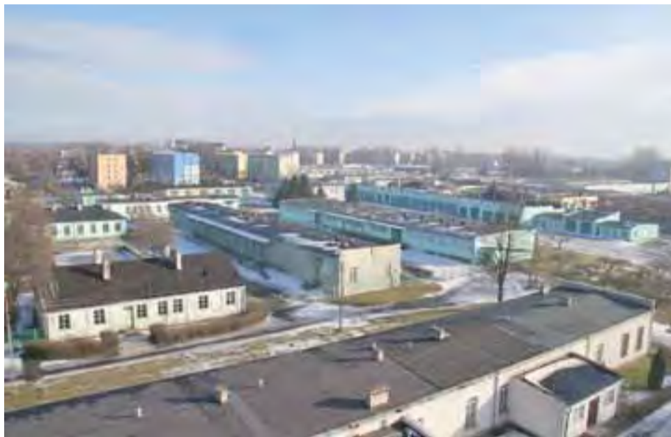
Teren byłej jednostki wojskowej w Łowiczu zajmuje blisko 6 hektarów i stoją na nim łącznie 32 budynki w różnym – w większości słabym, stanie technicznym.
