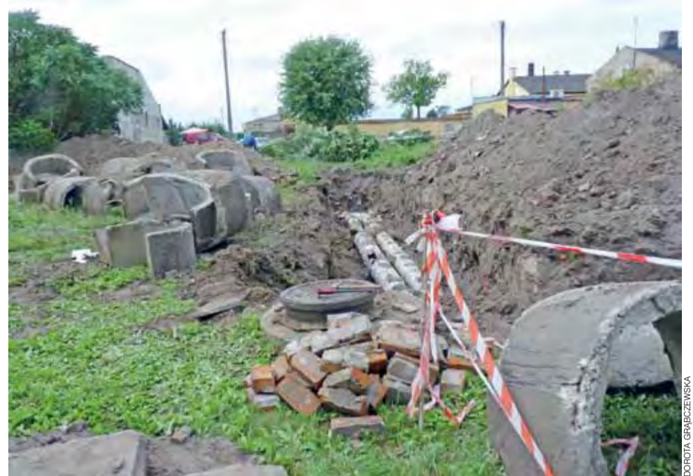
Na osiedlu Traugutta Zachód rozpoczęto modernizację 140 m ciepłociągu. Przez 2 tygodnie mieszkańcy miasta nie będą mieć ciepłej wody, gdyż trwa remont ciepłowni.
