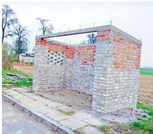
Trwa odbudowa przystanku w Kolonii Oporów. Przewracającą się wiatę rozebrano, a w jej miejsce zbudowano nowy przystanek. Wkrótce zostanie zadaszony.
