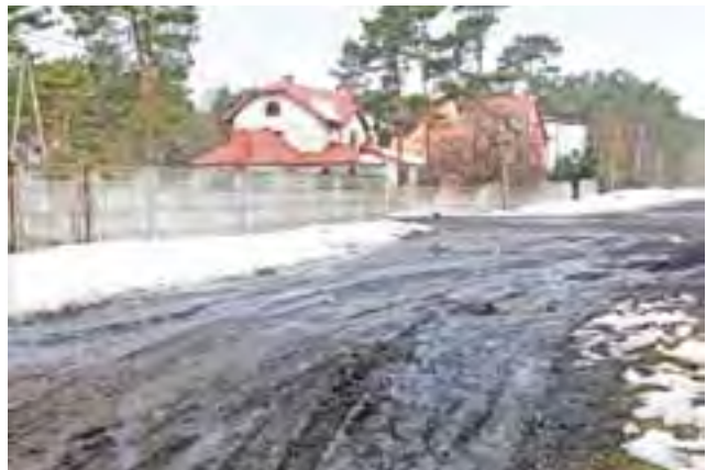
Ul. Ziewianicka po roztopach i już po wypompowaniu wody wygląda tak
