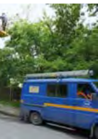
Prace konserwacyjne. To z ich powodu prąd jest wyłączany.
