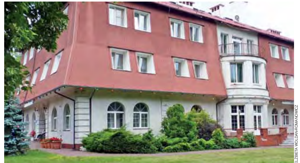
DPS w Głownie. Budynek z zewnątrz wygląda pięknie, ale wymaga kosztownych remontów.
