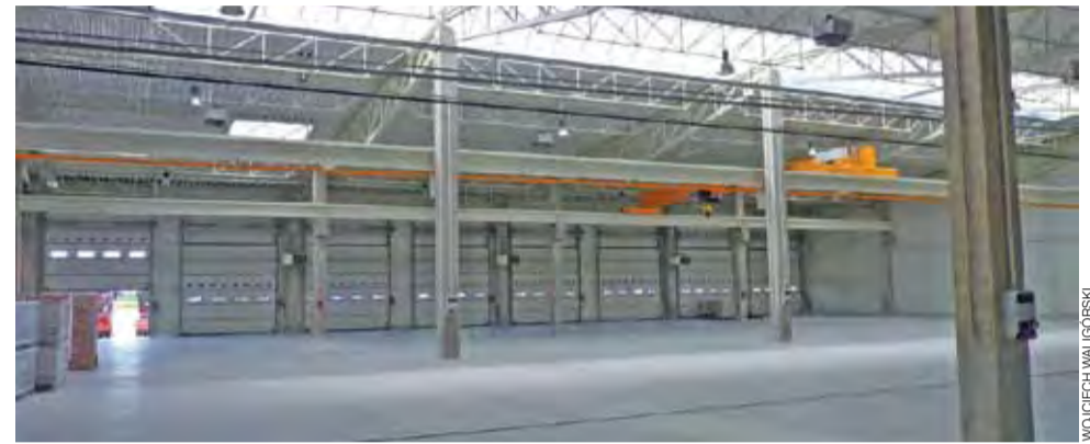
Hala serwisowa – na razie stoi pusta.
