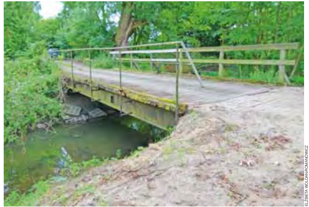
Poziomy wyrównane i nie ma już problemów z wjazdem na most między Ziewanicami a Gawronkami.
