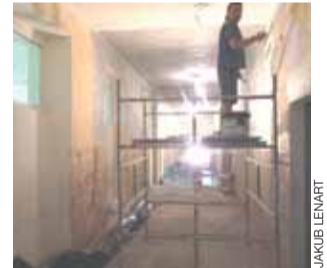
Korytarz na parterze przechodzi właśnie gruntowny remont.
