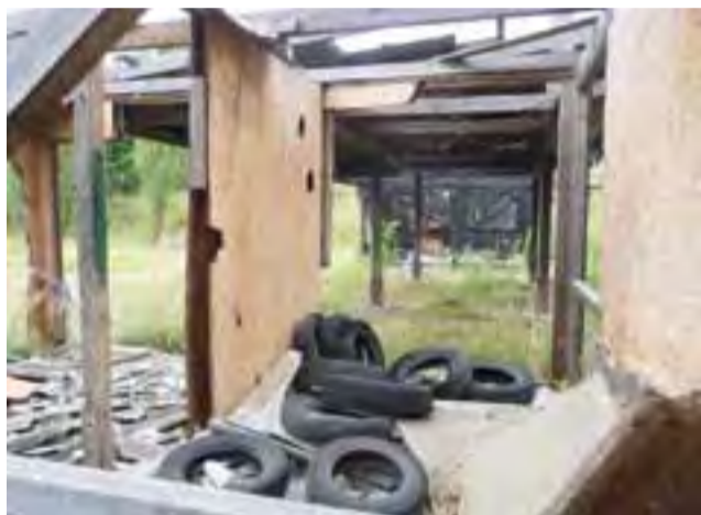
Ze starych opon dzieci układają sobie podest, po którym wchodzi na pozostałą konstrukcję dachu.
