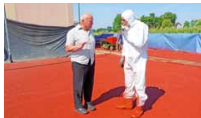
Prace na finiszu. Wójt gm. Głowno Marek Józwiak rozmawia w środę z wykonawcą prac w Makolicach, gdzie na nawierzchni boiska i bieżni zostały jeszcze do wyznaczenia linie.
