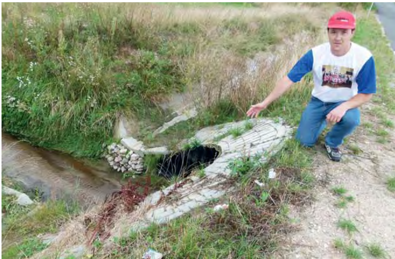
Sołtys Woli Błędowej Jarosław Włodarczyk pokazuje miejsce przy drodze powiatowej, gdzie krzyżuje się pogłębiony rów odwadniający z okazałą wielkością przepustem.
