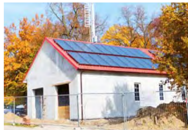
Już z zewnątrz widać, że inwestycja nastawiona jest na ekologię. Na dachu nowej kotłowni kilkadziesiąt solarów, pozostałe na budynkach OHP po przeciwnej stronie ulicy.
