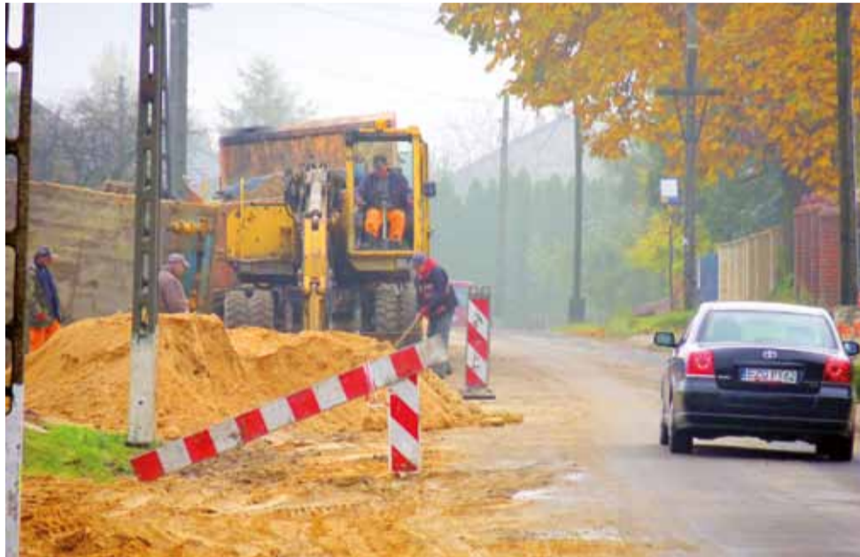
Utrudnienia na Targowej potrwać jeszcze około miesiąca. Stan prac na 17 października.
