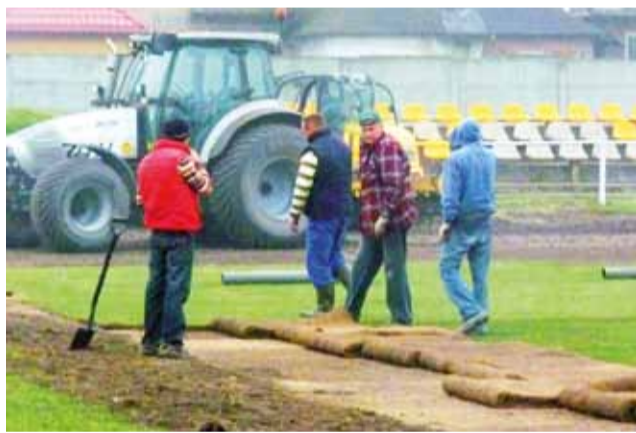
Prace prowadziła ekipa z warszawskiej firmy Dropservice.
