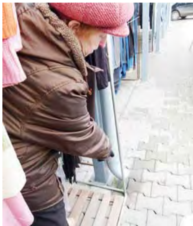
Pani Barbara pokazuje rynnę , z której na jej stanowisko po deszczach spływa woda.
