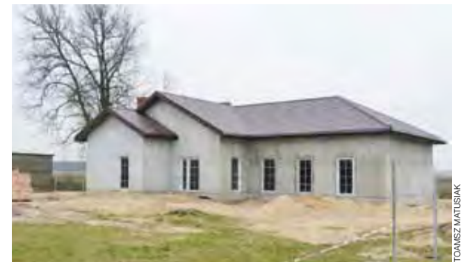
Świetlica jest już wykończona od zewnątrz. Teraz trwają prace w środku.
