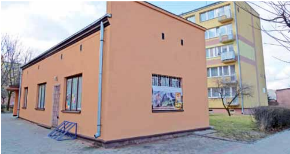
Budynek w środku os. Stary Rynek. Był w nim sklep, ma być świetlica i siedziba strykowski koła emerytów.
