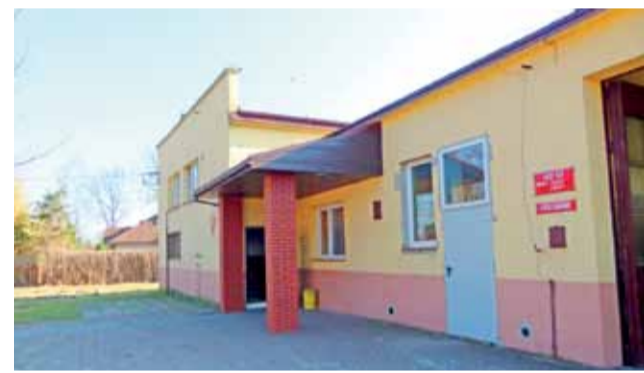
Budynek jednostki OSP w Dobrej, gdzie w tym roku planowany jest remont dachu.
