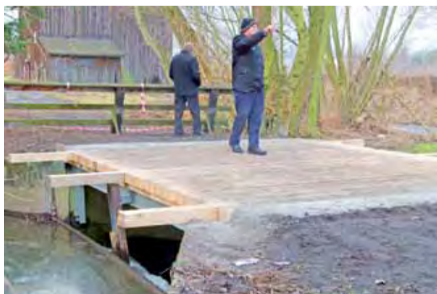
Remont mostu w Boczkach Domaradzkich. Stan na 21 lutego.
