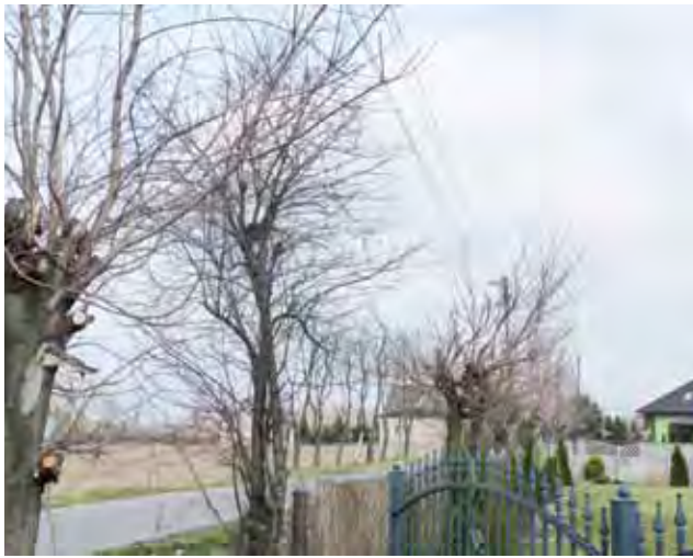
Gałęzie drzew rosnących wzdłuż linii zagrażają bezpieczeństwu.
