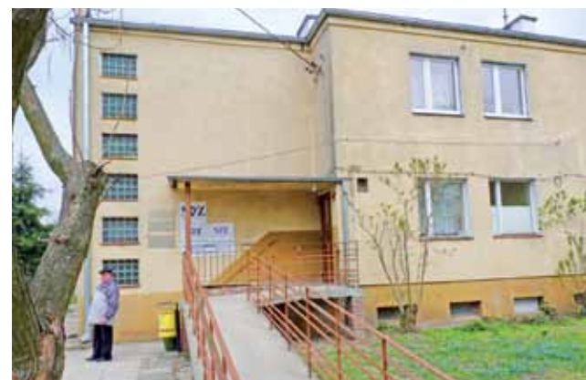
Ośrodek zdrowia w Bratoszewicach. Tutaj ekipie remontowej zostało już niewiele do zrobienia.
