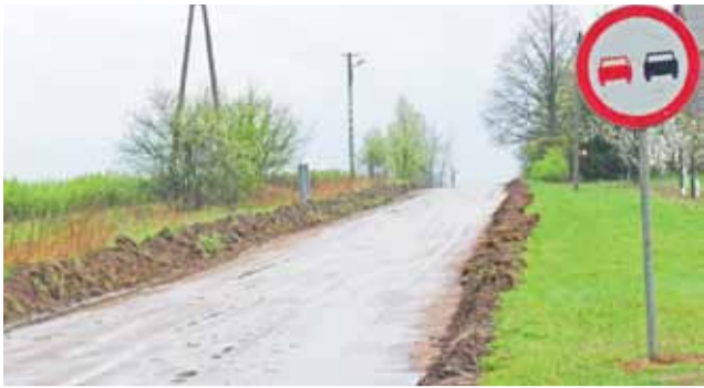
Ulica Zatorze w Bratoszewicach już przygotowywana do utwardzenia.
