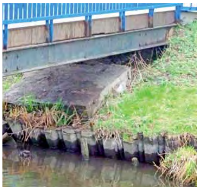
Stan umocnień skarp przy przyczółkach budzi niepokój naszego czytelnika
