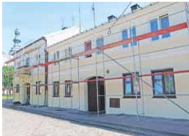
Po demontażu rusztowań, budynki będą jak nowe – ale tylko od frontu.
