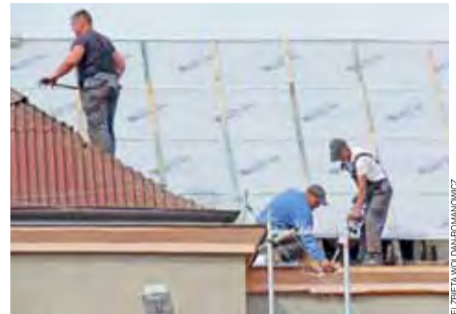
Remont szkoły w Mąkolicach. Przed wymianą dachu skuwano gzymsy.
