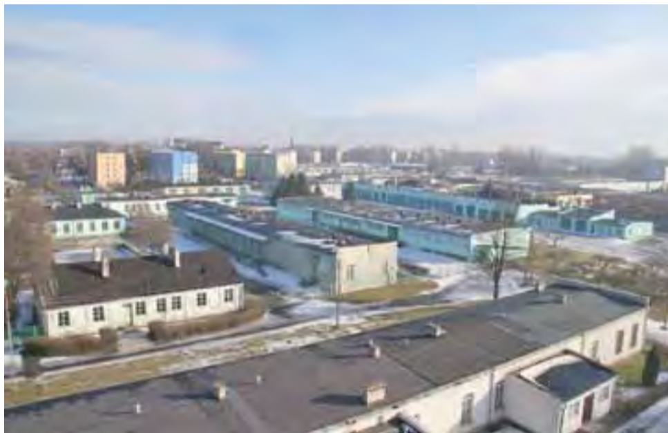
Teren byłej jednostki wojskowej w Łowiczu zajmuje blisko 6 hektarów i stoją na nim łącznie 32 budynki w różnym – w większości słabym, stanie technicznym.
