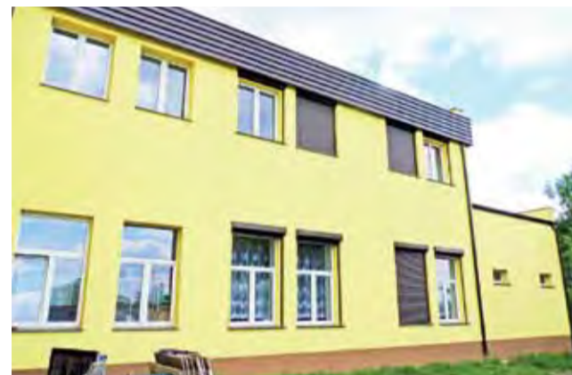
Południowa ściana GOK-u także wygląda teraz estetycznie.
