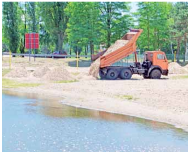
Na plażę piasek przywożony jest wywrotekami.
