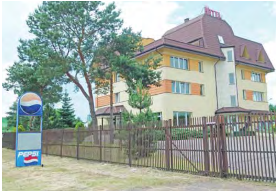
Majątek sprzedany. Obecnie we wnętrzach dawnego hotelu Varius nowy właściciel prowadzi remont.
