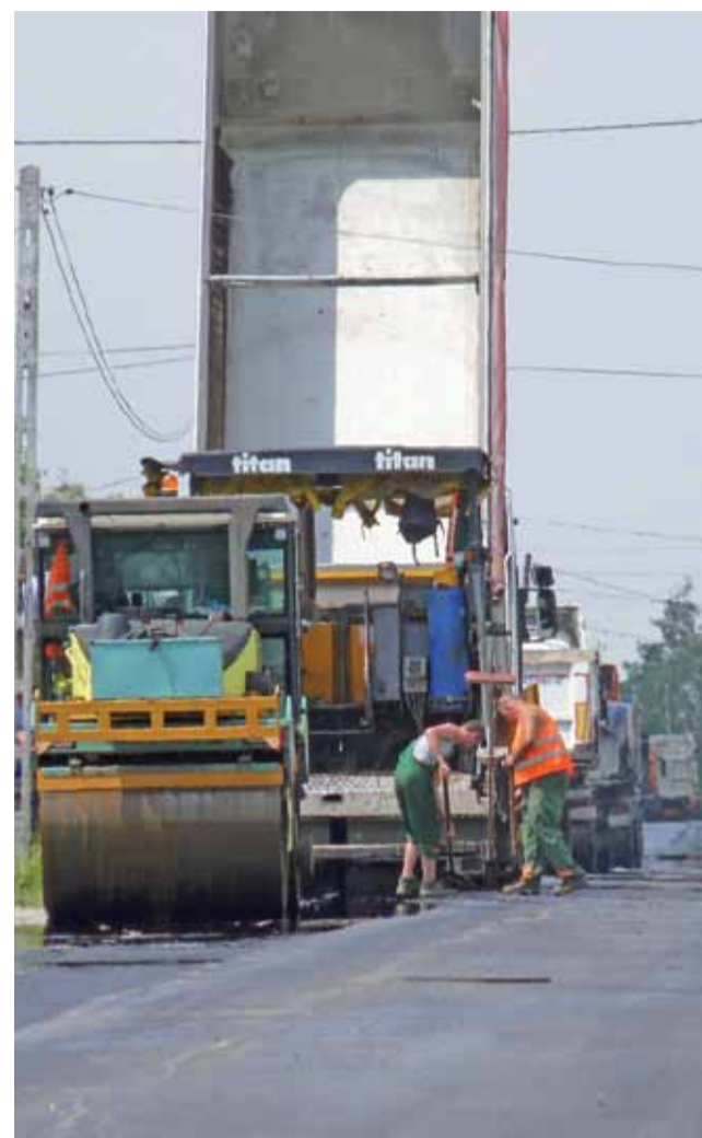
Wylewanie asfaltu na Wolskiej. Odbudowa drogi powiatowej w Bratoszewicach, stan na 9 lipca.
