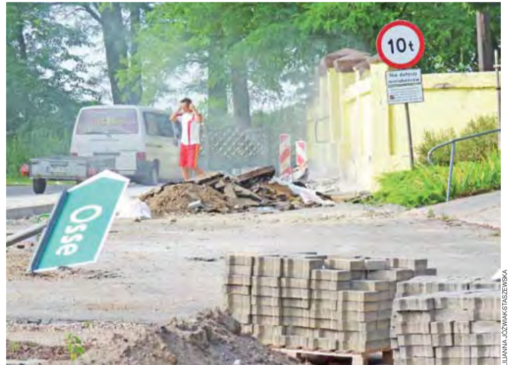
Prowadzone obecnie w obrębie skrzyżowania i wylotu w kierunku Ossego roboty uproszczą organizację ruchu w tym miejscu. Zamiast krótkiego odcinka drogi, przy kościele wygospodarowany zostanie parking.
