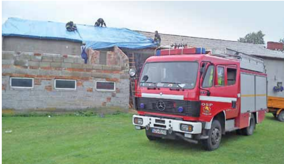
Interwencja przy zerwanym dachu budynku gospodarczego w Swędowie.
