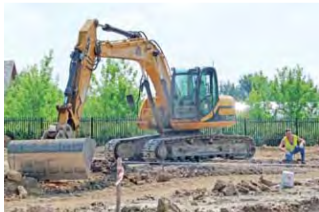
Trwają prace na budowie boiska przy SP1.
