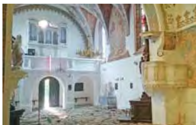
Niecodzienny widok. Remont posadzki kościoła w Sobocie w gm. Bielawy.
