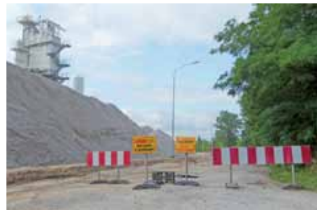
W miejscu ul. Zakładowej, której uruchomienie zapowiadano już w ubiegłym roku, nadal teren budowy.
