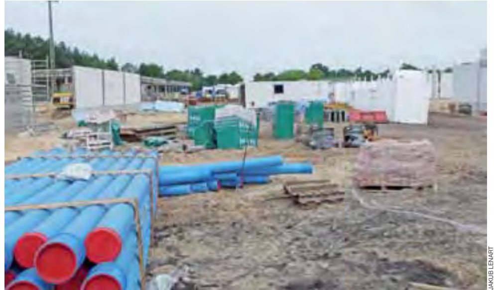
Choć wydaje się pusto, to na placu budowy pracuje około 30 osób (w chwili robienia zdjęcia budowlancy mieli przerwę).
