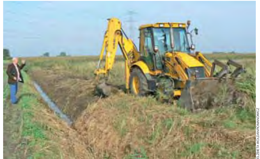
Prace konserwacyjne. Trwa odmulanie rowu melioracyjnego w okolicach Różan, stan na 12 września.
