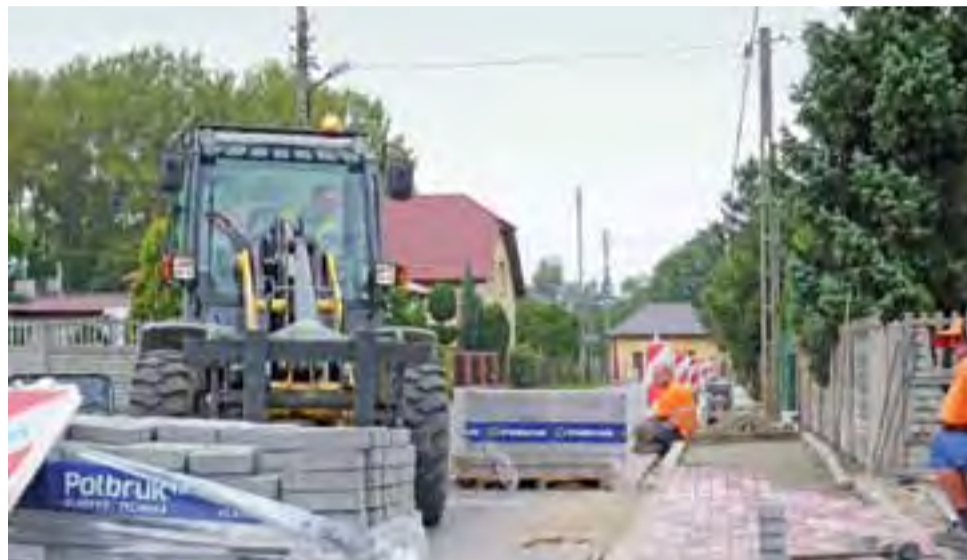
Końcowy odcinek modernizowanego chodnika w Smolicach – ostatnie dni robót.
