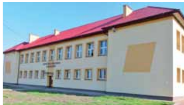
Pod nowym dachem. Docieplony i wyremontowany budynek ZSP.
