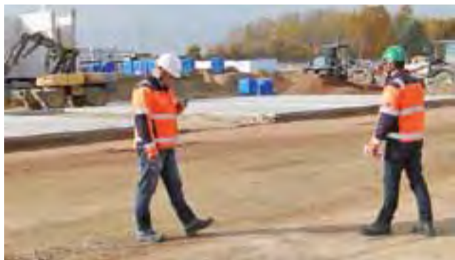
Na placu budowy nowego centrum przeładunkowego.
