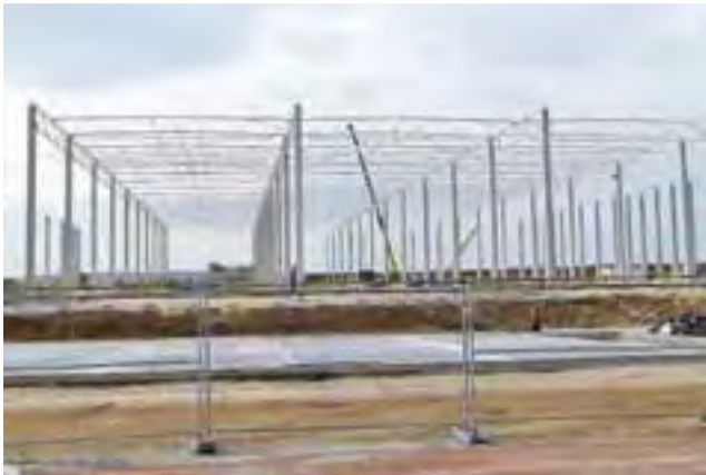
Na placu budowy nowego centrum przetadunkowego stoją już stopy nośne jednej z hal.
