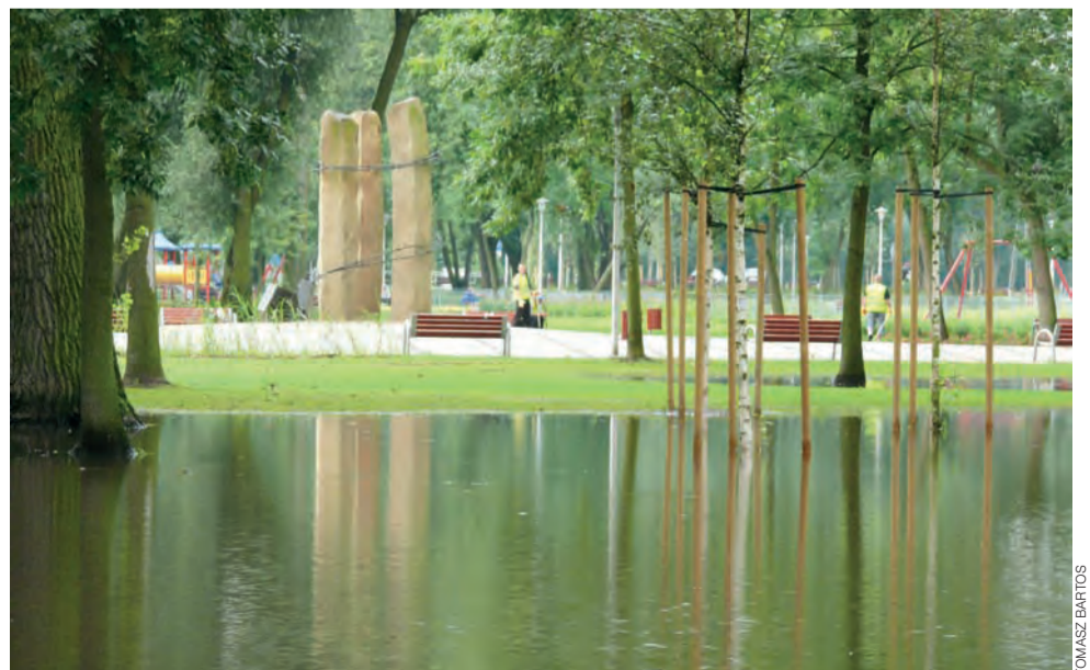
W środku lata Park Błonie w Łowiczu znowu był zalany – źle zamontowano kraty kanalizacji deszczowej. Po naprawie ma być lepiej.
