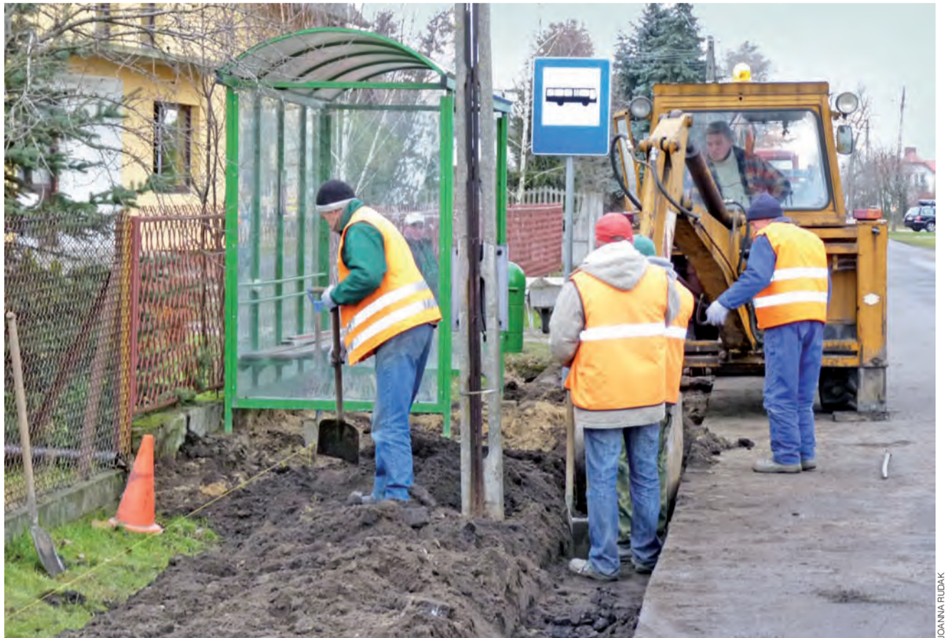
Pracownicy firmy Budomix kładą chodnik, pomimo stojących w tym miejscu słupów Telekomunikacji.
