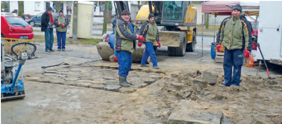
W poniedziałek, 9 stycznia, pracownicy uzupełniali jeszcze płyty chodnikowe po naprawie niedzielnej awarii.
