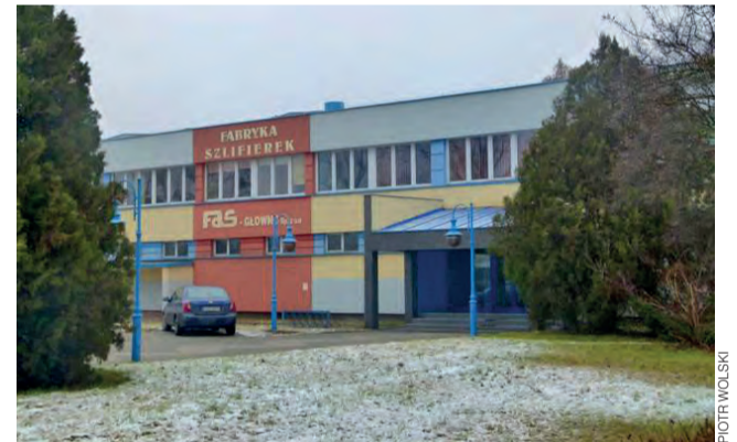
W tym budynku pracuje obecnie jeszcze blisko 80 osób.
