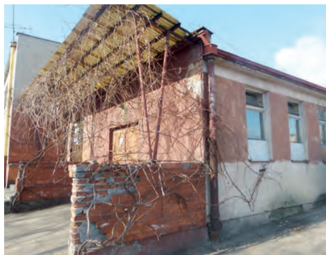
Budynek lecznicy weterynaryjnej przy ul. Jabłońskiego 3 w Głównie
