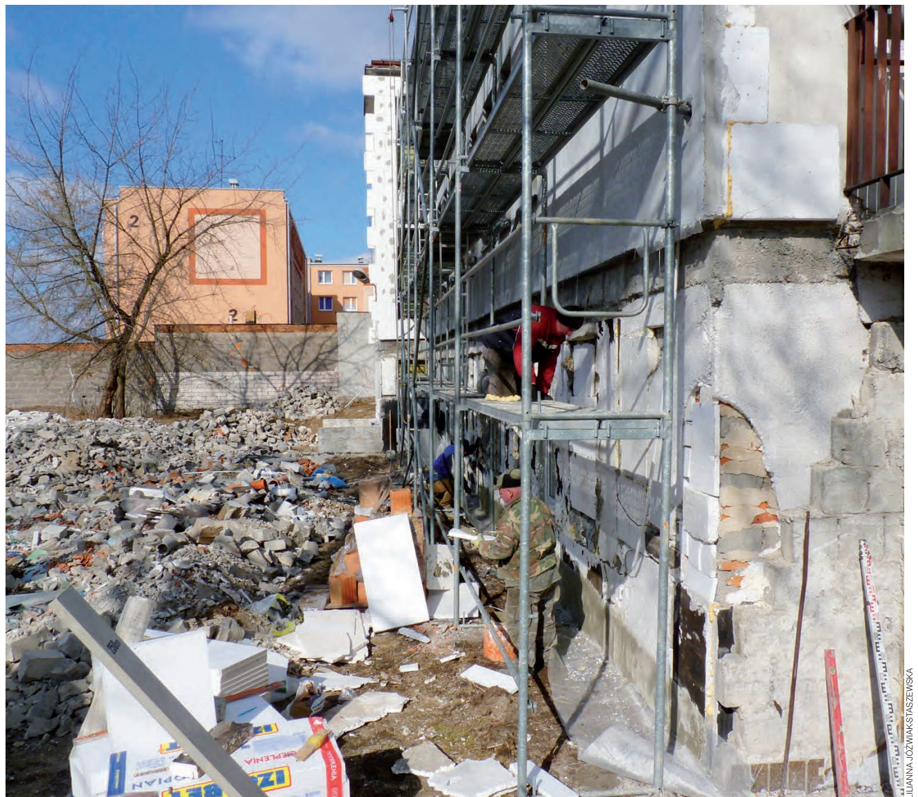
Gruz wyrzucony z piwnicy i zbity ze ścian przychodni zajął cały wewnętrzny parking. Obecnie trwa docieplanie ścian.
