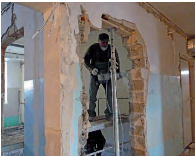
Piwnica, w której była rehabilitacja, przechodzi totalną metamorfozę.
