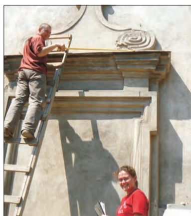
Pracownicy firmy Budowa dokonują szczegółowych opisów elewacji.
