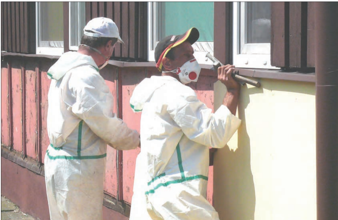
Pracownicy łowickiej firmy Anwo Andrzeja Wołynika dokonali demontażu azbestowych płyt na przedszkolu nr 2 w Łowiczu. Firma była podwykonawcą.
