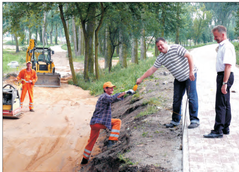
Burmistrz Krzysztof Kaliński (pierwszy od prawej) ogląda postęp prac przy budowie podjazdu dla wózków.
