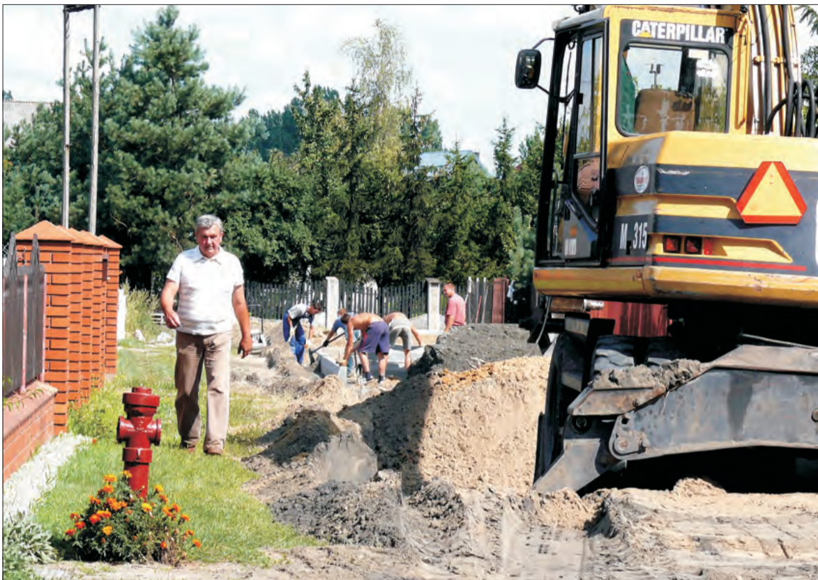
Ulice Kajaka i Stroynowskiego rozkopane na całej długości.
