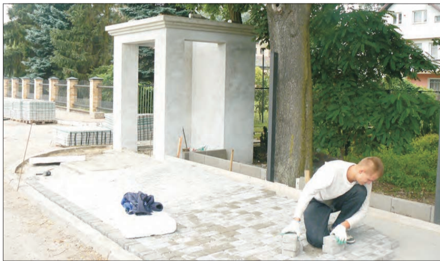
Obecnie przed kościołem w Boczkach są już nowe chodniki, trwają prace wzdłuż parku.
