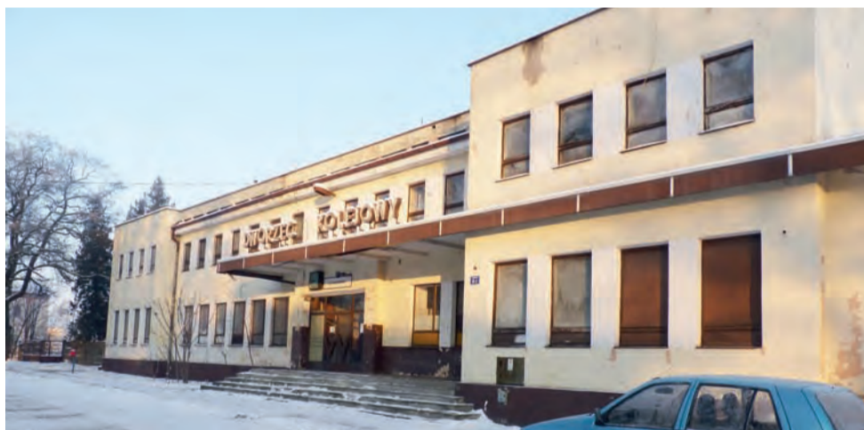
W tym roku ma być przeprowadzony cząstkowy remont dworca. Zrobiony będzie dach, wymienione okna.
