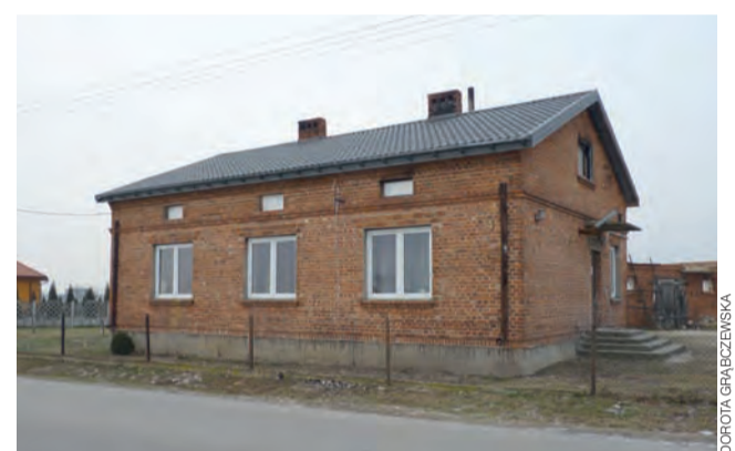
Po pożarze, dzięki pomocy sąsiadów i okolicznych mieszkańców, na domu jest już nowy dach.
