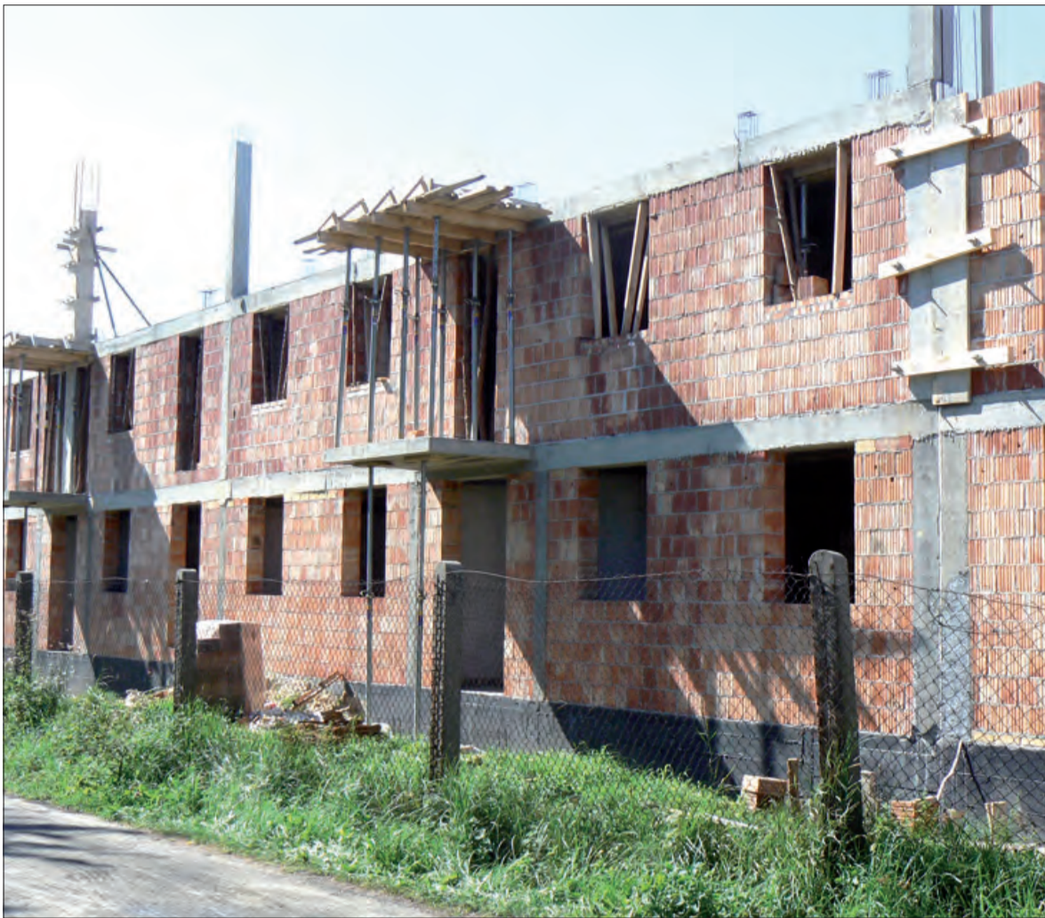
Dwie kondygnacje budynku już stoją.
