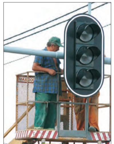
Na skrzyżowaniu trwa montaż sygnalizacji świetlnej, zakończy się w tym tygodniu.
