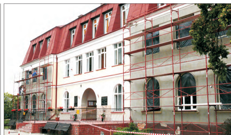
Główny budynek szkoły blichowskiej będzie po remoncie wyglądał jak nowy.
