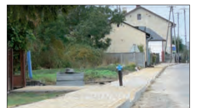
Ulica Parzew w Bielawach ma już chodnik po obu stronach.
