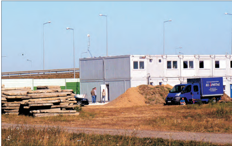
Baza robocza ekip przygotowujących autostradę do opłat rozlokowała się tuż za strykowskim wiaduktem na „czternastce”.
