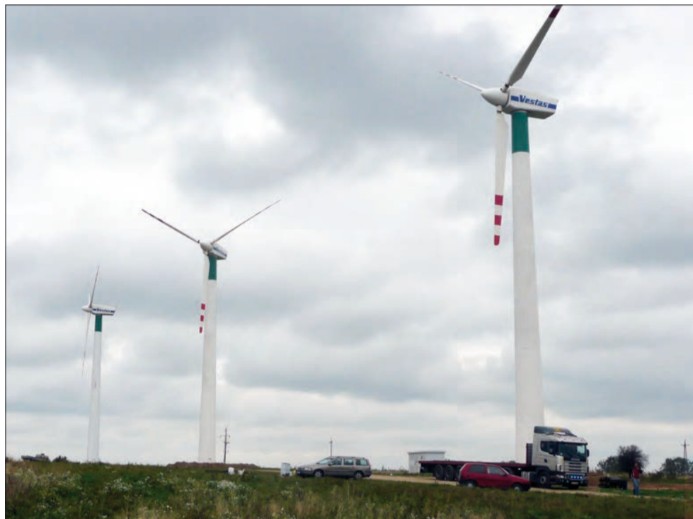
Na zdjęciu wiatraki marki Vestas o mocy 0,85 MW pracujące już od roku pod Kołacinkiem w gminie Dmosin. Te, które mają powstać pod Złakowem, będą jeszcze większe.
