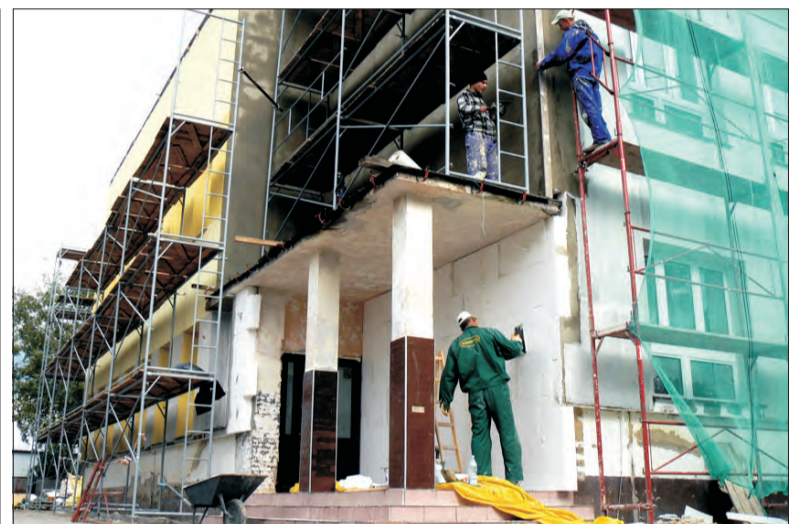
Docieplenie szkół w Bielawach dobiega już końca. Pozostało tylko dokończyć zewnętrzne tynki.
