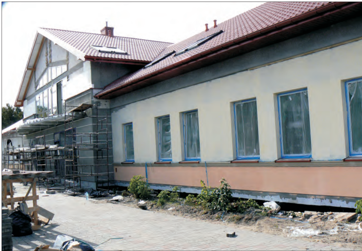
Prace przy nowym budynku starostwa zmierzają do końca.
