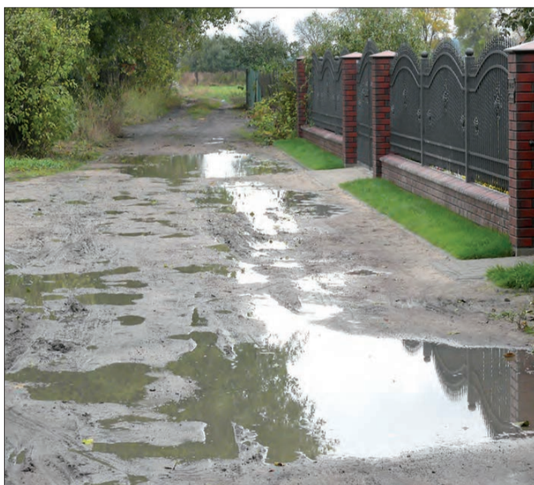
Stojąca woda i błoto na nieutwardzonym fragmencie ulicy Kiernozkiej.
