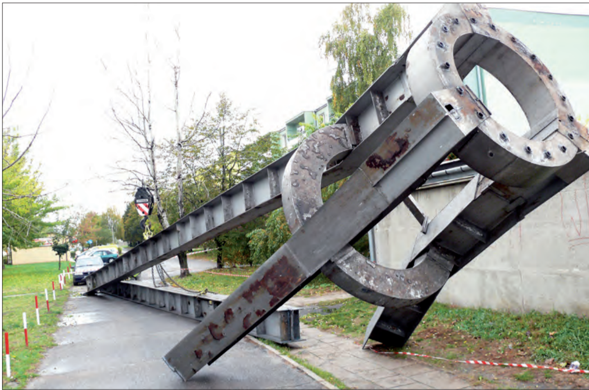
Zdemontowany trójnog kominu, który stał przy jednym z bloków na os. Bratkowice.
