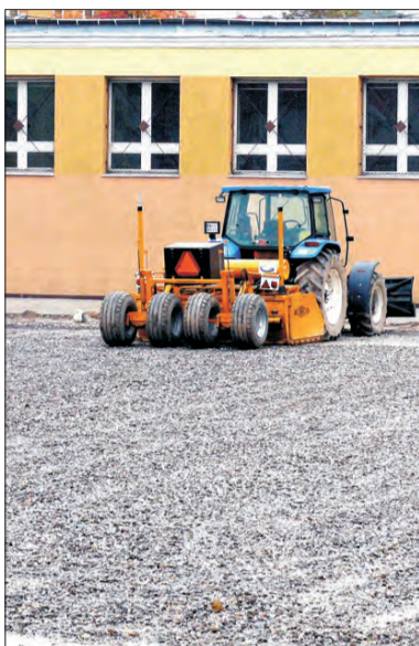
Postęp prac na boisku przy „Jedynce” - stojący od kilku dni w tym samym miejscu traktor.
