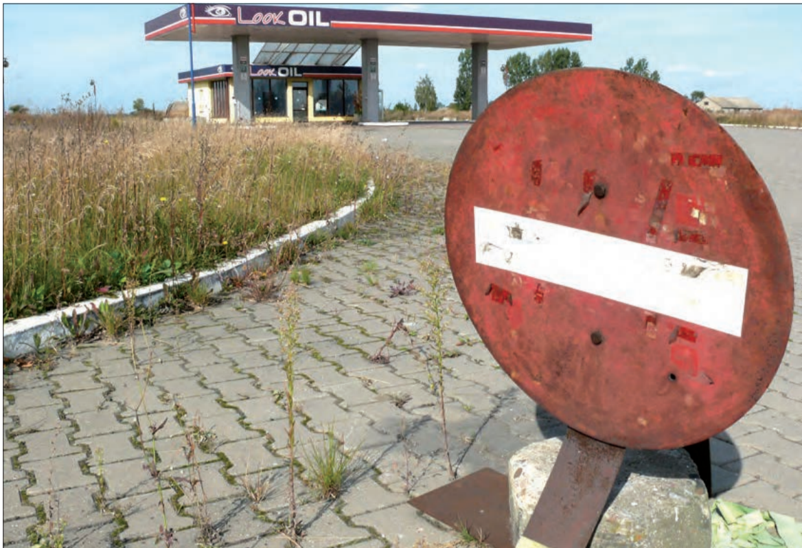
Stacja paliw Look Oil pod Kutnem niszczeje już od kilku lat.
