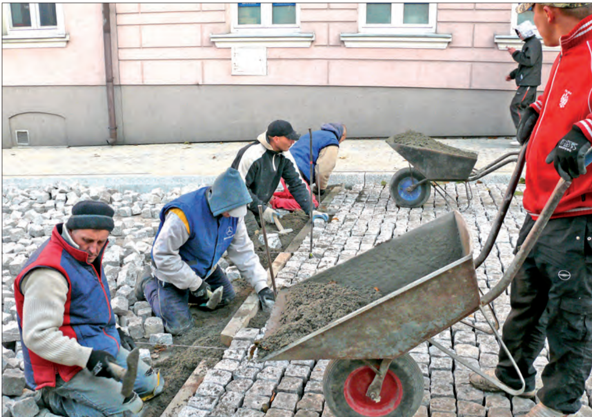
Pracownicy kutnowskiej firmy Trakt układają kostkę - zdjęcie z 2 listopada.
