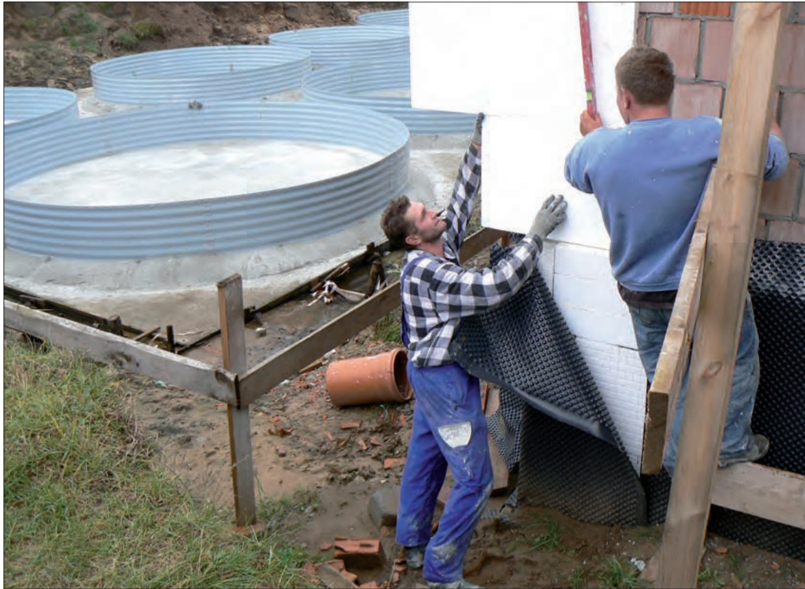
Sześć zbiorników na oczyszczalni w Bolimowie zostało już zamontowanych. Trwają prace przy ich podłączeniu do sieci oraz prace wykończeniowe budynku socjalno-technicznego
