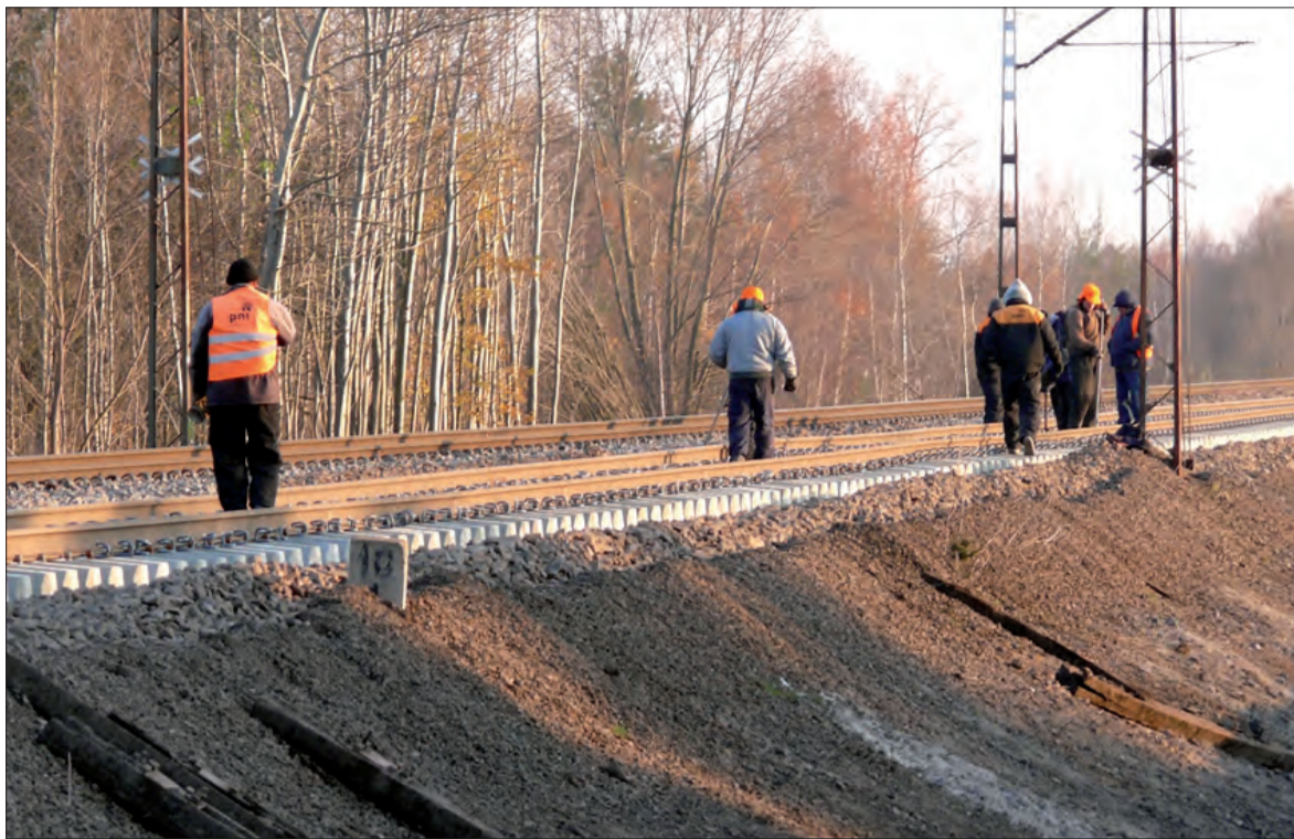
Prace przy modernizacji torów do Skierniewic mają zakończyć się pod koniec listopada.
