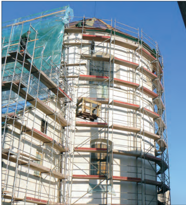
Obecnie trwają prace wykończeniowe na dachu absydy.
