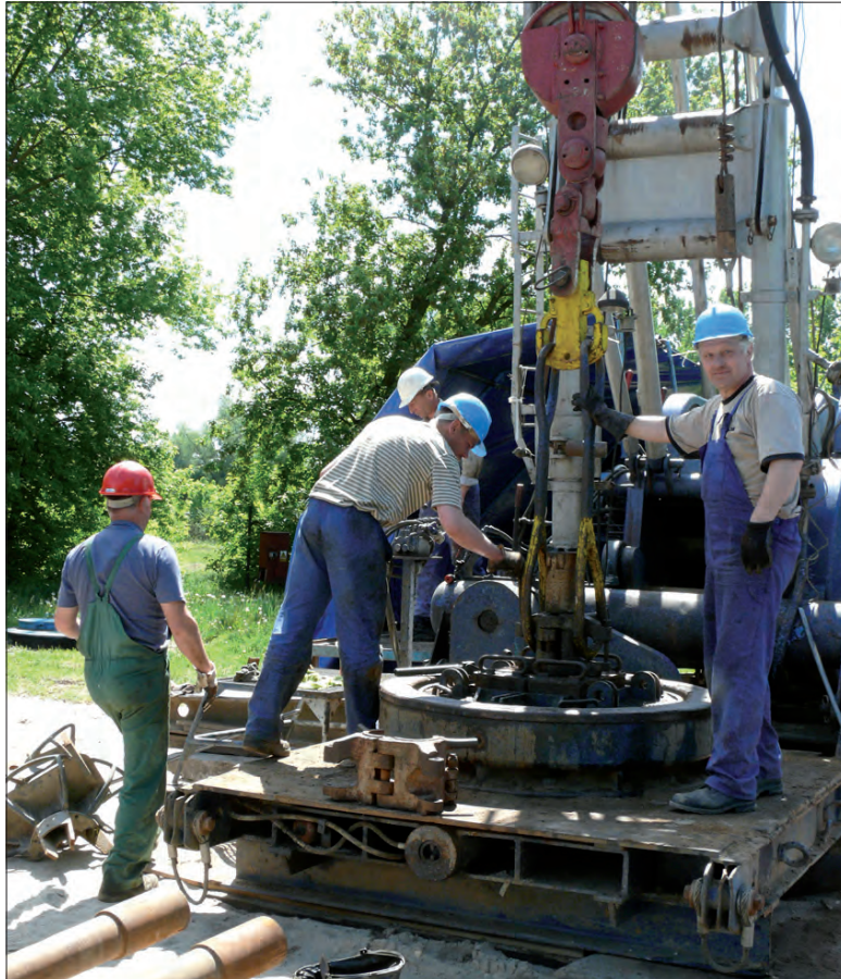
Unia pomaga miastu Łowicz zmodernizować studnię głębinową.
